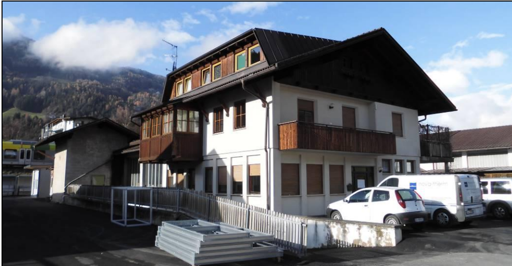
Nord-Ost Ansicht des Betriebsgebäudes mit Rampe und Haupteingang
