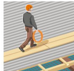
Regel 5: Wir arbeiten nur auf durchbruch-sicheren Dachflächen.
