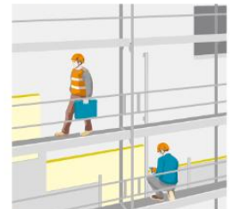
Regel 6: Wir verwenden für Fassadenarbeiten ein sicheres Gerüst oder eine Hubarbeitsbühne.
