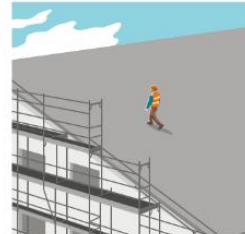
Regel 2: Wir sichern die Absturzkanten am Dachrand ab 2 m Höhe.
