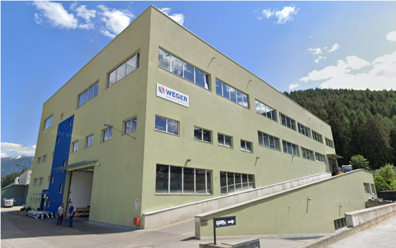
Nord-West Ansicht des Betriebsgebäudes mit Zufahrtsrampe und Haupteingang
