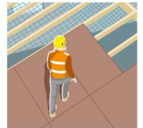
Regola 3: Ci proteggiamo contro le cadute all'interno dell'edificio da un'altezza di caduta di 2 m.
