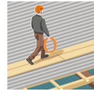
Regola 5: Lavoriamo solo su superfici di tetti resistenti alle penetrazioni.
