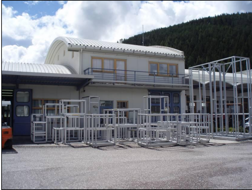
Nord-West Ansicht des Betriebsgebäudes mit Rampe und Haupteingang
